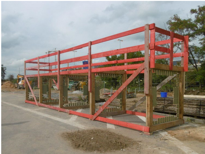
Montagegerüst für Stützenbewehrung
