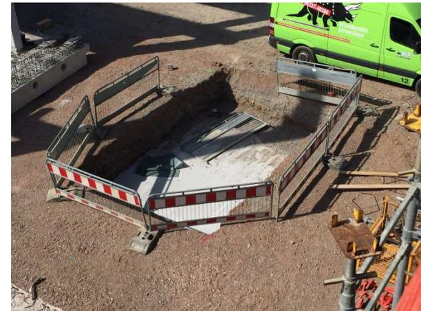
Bei der Festlegung von Fahrwegen müssen Aufgrabungen berücksichtigt und dann in ausreichendem Abstand abgesperrt werden
