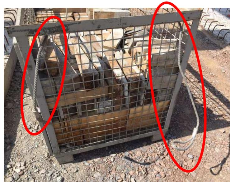
alte Gitterboxen sind nicht für den Kranbetrieb zugelassen: falsches Anschlagen vorprogrammiert
