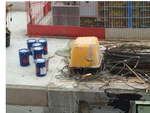
Mörtelwannen sind nur für den Transport von sich selbst stellendem Material zugelassen !!!
