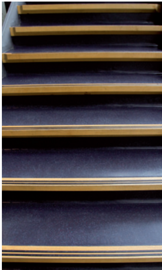
Abb. 16 Treppe mit rutschhemmenden, optisch klar abgehobenen Stufenkanten
