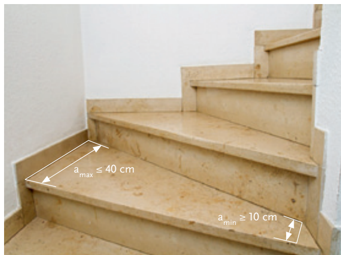
Abb. 3 Zulässige Auftrittstiefen an gewendelten Treppenstufen
